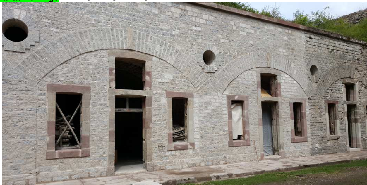
03.05 : Suite des joints de la façade-Nord de la 2° cours d'honneurs : un jeu de patience !!! - Fin en 2018
